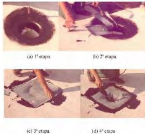
*Figura 3 -Execução do arremate de impermeabilização junto ao ralo.*
