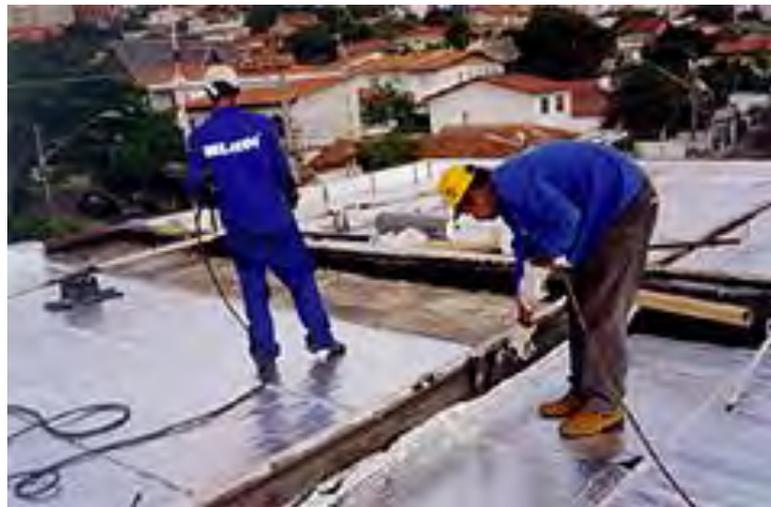
*Figura 14: Colagem a quente de manta asfáltica*
