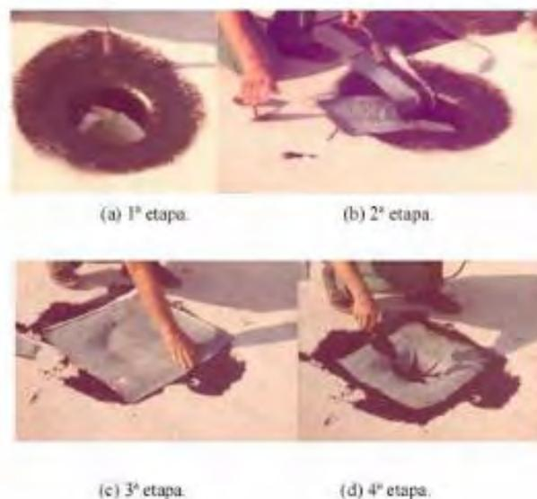
*Figura 13 -Execução do arremate de impermeabilização junto ao ralo.*
