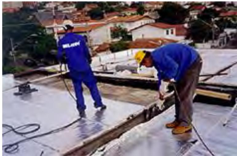
*Figura 4: Colagem a quente de manta asfáltica*
